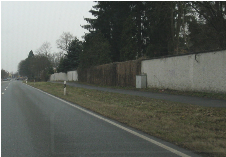
Lärmschutzwand entlang der B 14; die Bahntrasse befindet sich links der Straße
